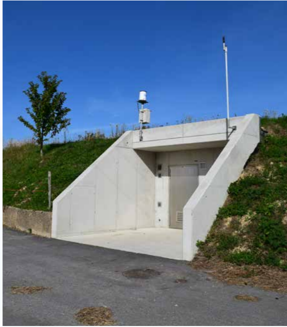
Station de pompage Condémine à Montet. (2018)
