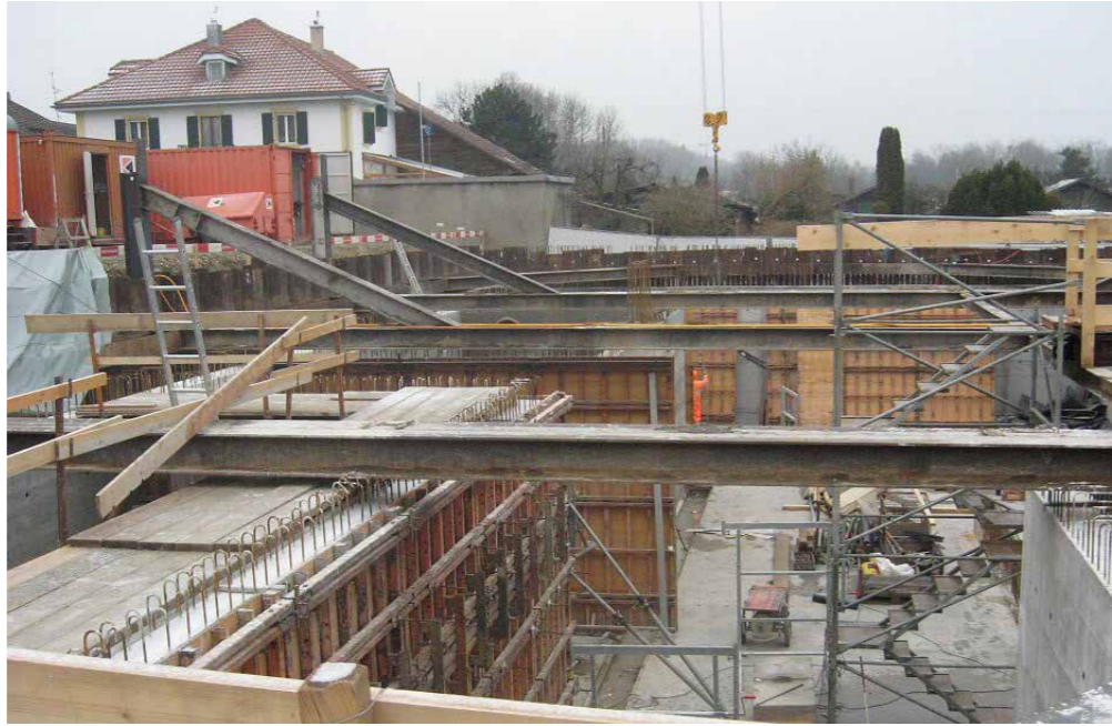
Construction de la station d'ultrafiltration à Cudrefin. (2011-2012)
