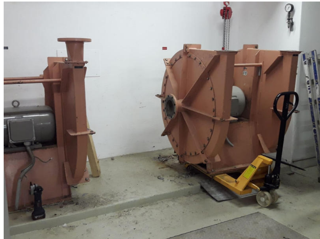
Démontage et évacuation des anciens surpresseurs
