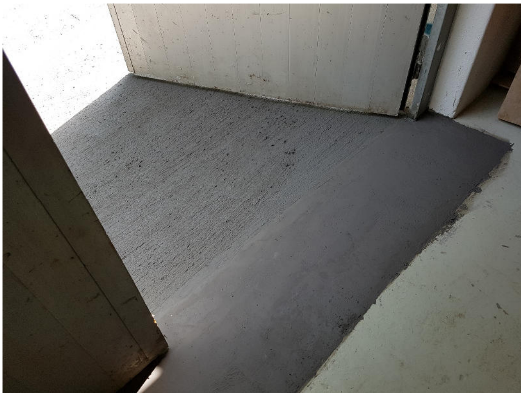
Réalisation du seuil en pente douce, à l'arrière du bâtiment
