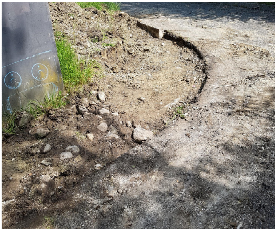
Démontage de la bordure de la route d'accès à la place arrière
