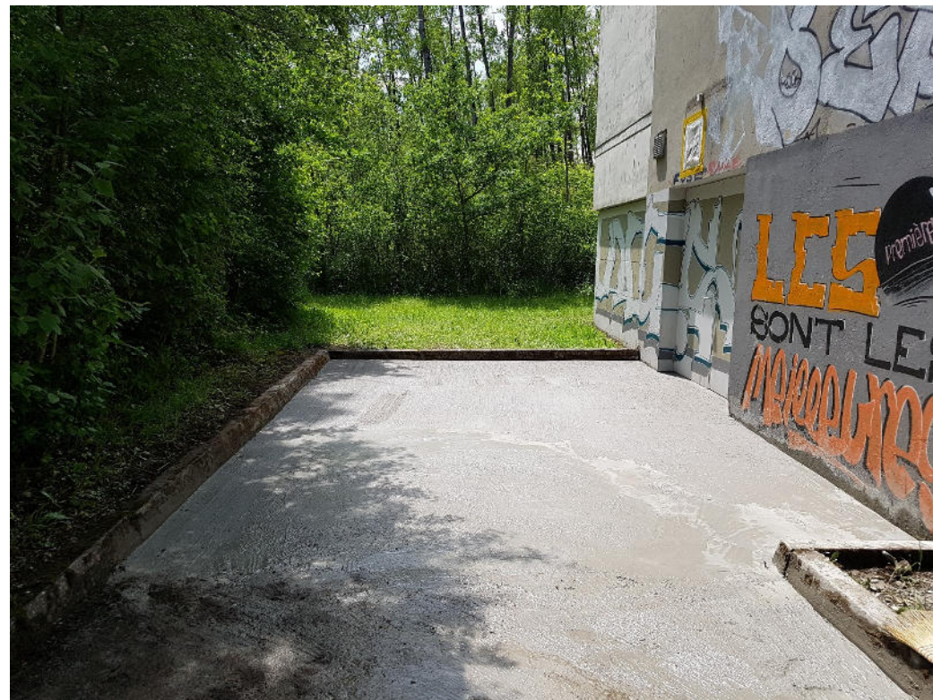
Finalisation de la dalle en béton à l'arrière du bâtiment
