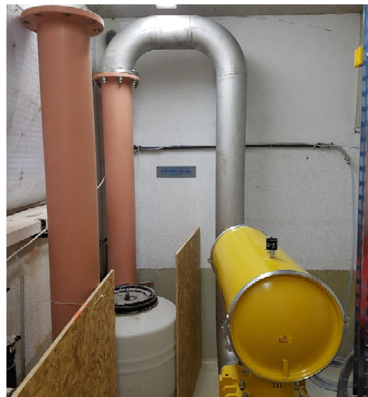
Pose de la nouvelles conduite inox pour le surpresseur
