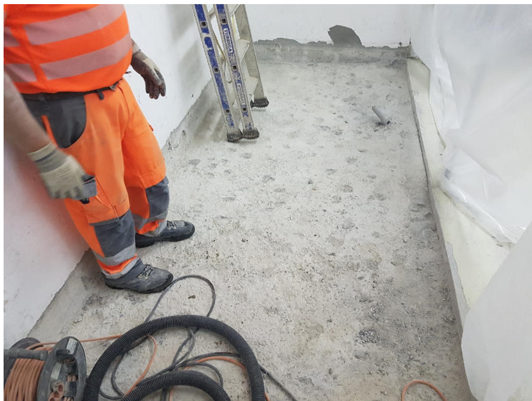
Démontage des socles des anciens surpresseurs
