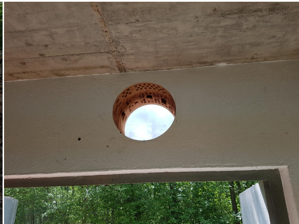
Carottage d'un trou dans le mur de la halle principale pour le système de ventilation
