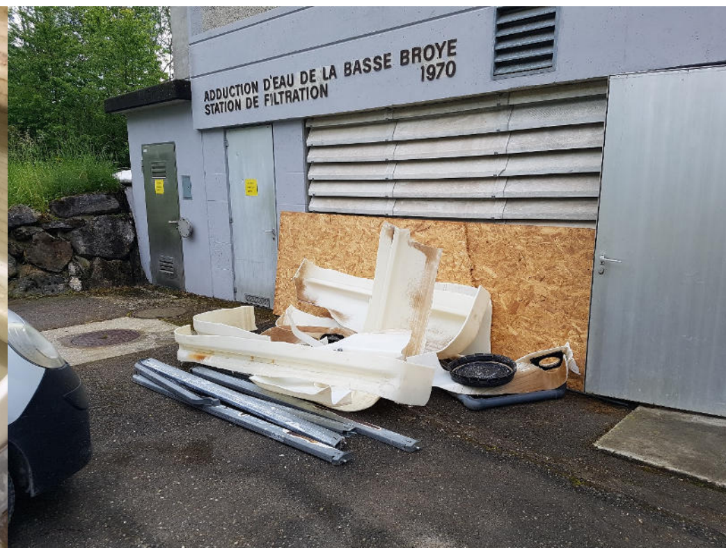
Ancienne cuve WAC démantelée
