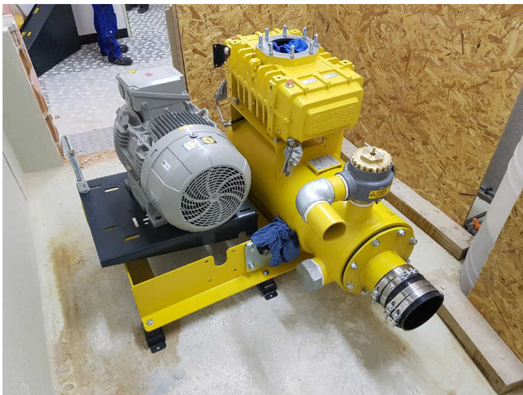
Montage du nouveau surpresseur à l'emplacement de l'ancienne cuve WAC
